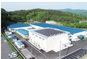
太陽光発電設備 (屋上部) (東北ヒロセ電機)
