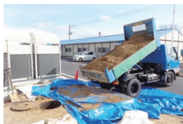
重油地下タンクの埋め戻しの作業 (郡山ヒロセ電機)
