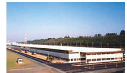
フジクラ・ダイヤケーブル福井工場
