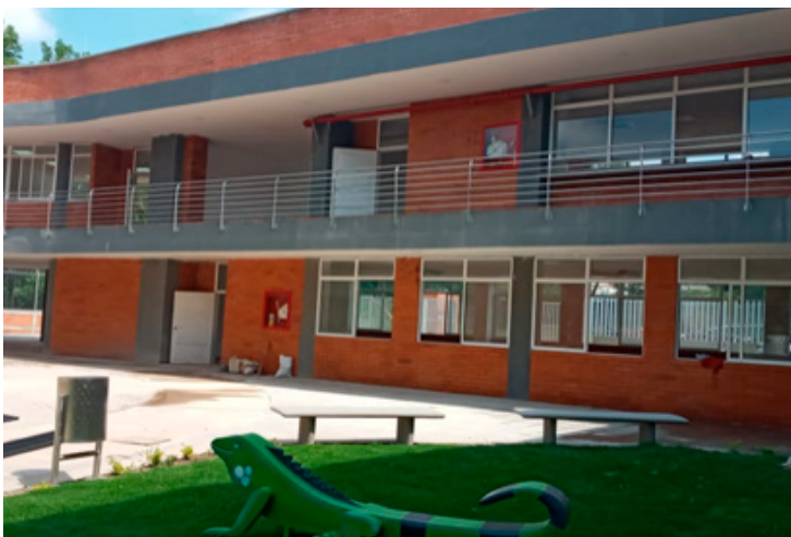
Construcción fase II colegio La Fortuna
