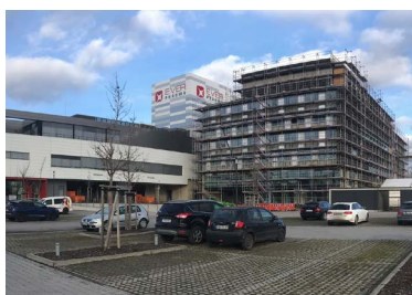
Der energieeffiziente Neubau der EVER Pharma Jena befindet sich auf der Zielgeraden.
