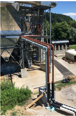
Wärmeauskopplung bei der TKV
