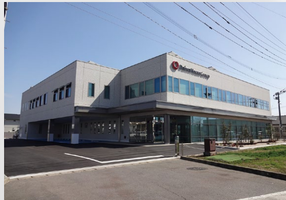
電力自給自足ビル(大和ハウス佐賀ビル)
