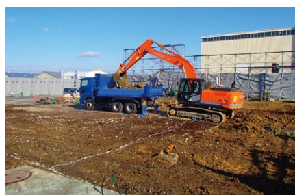
奈良工場 汚染土積み込み作業
