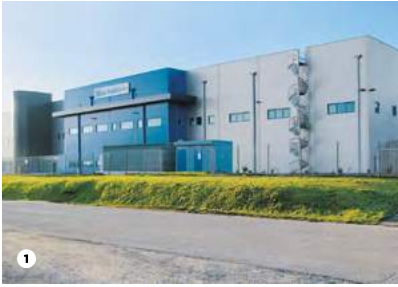
1. Usine de batteries sur le site de Pen-Carn d'Ergué-Gabéric, en Bretagne.
