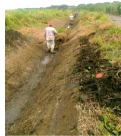
Limpieza de canales
