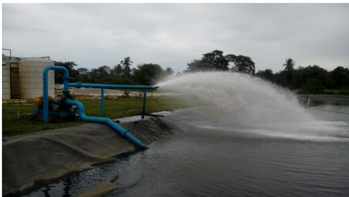
Enfriamiento de agua
