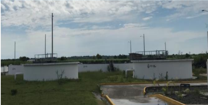
Sistema de Filtración
