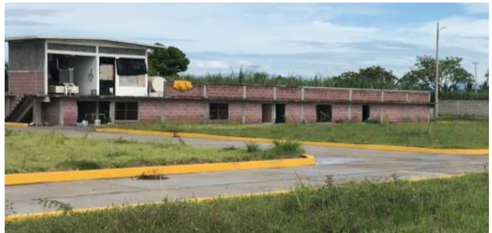
Cuartos de control y Planta de Emergencia
