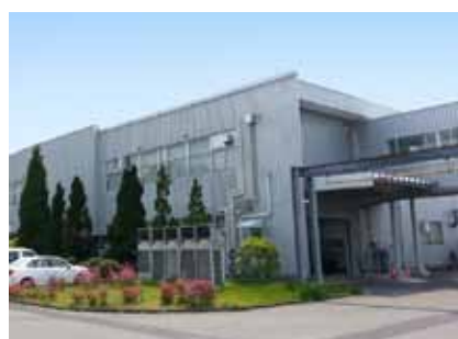
めっき棟（一関ヒロセ電機）
