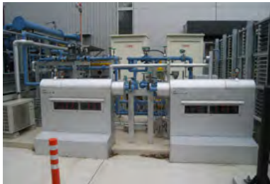
水冷式ヒートポンプ空調システム
