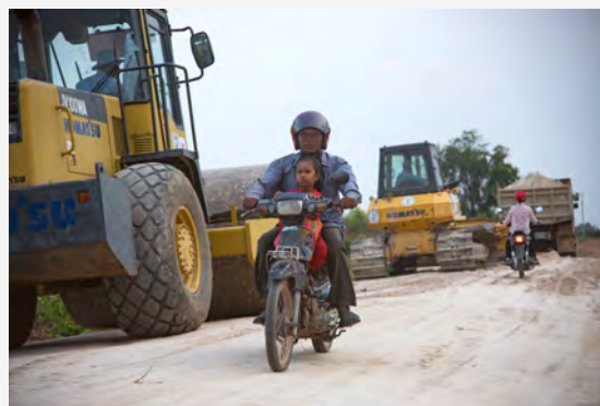
道路建設では多くの建機が稼働
