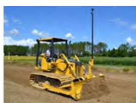
小型ICTブルドーザによる田面均平化作業
