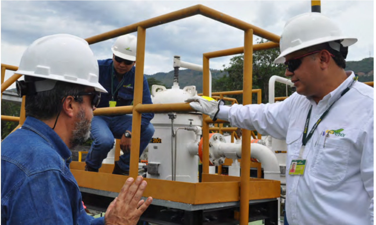
Trabajadores en la Estación Chimita Departamento de Santander.
