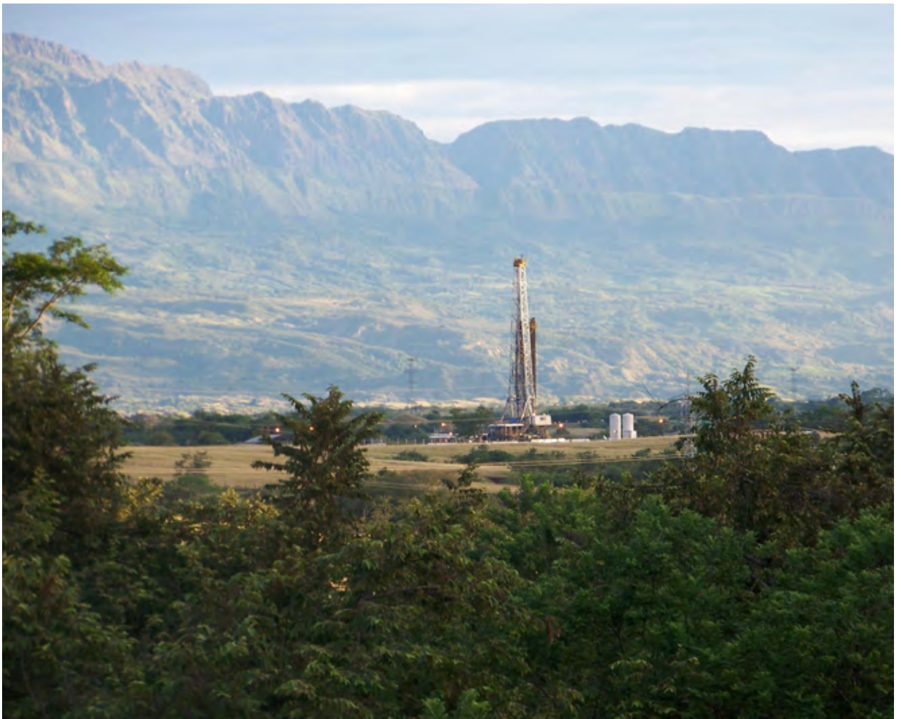
Ecopetrol, Torre de exploración en Tenay. Departamento del Huila.
