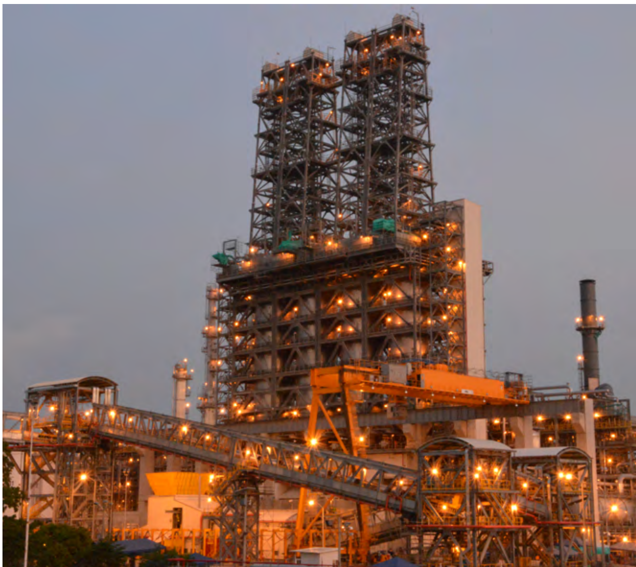
Ecopetrol. Planta de coque. Reficar. Departamento de Bolívar.
