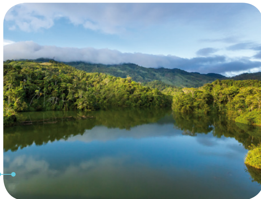
Embalse de la Central Hidroeléctrica Jaguas (170 MW) en Antioquia.
