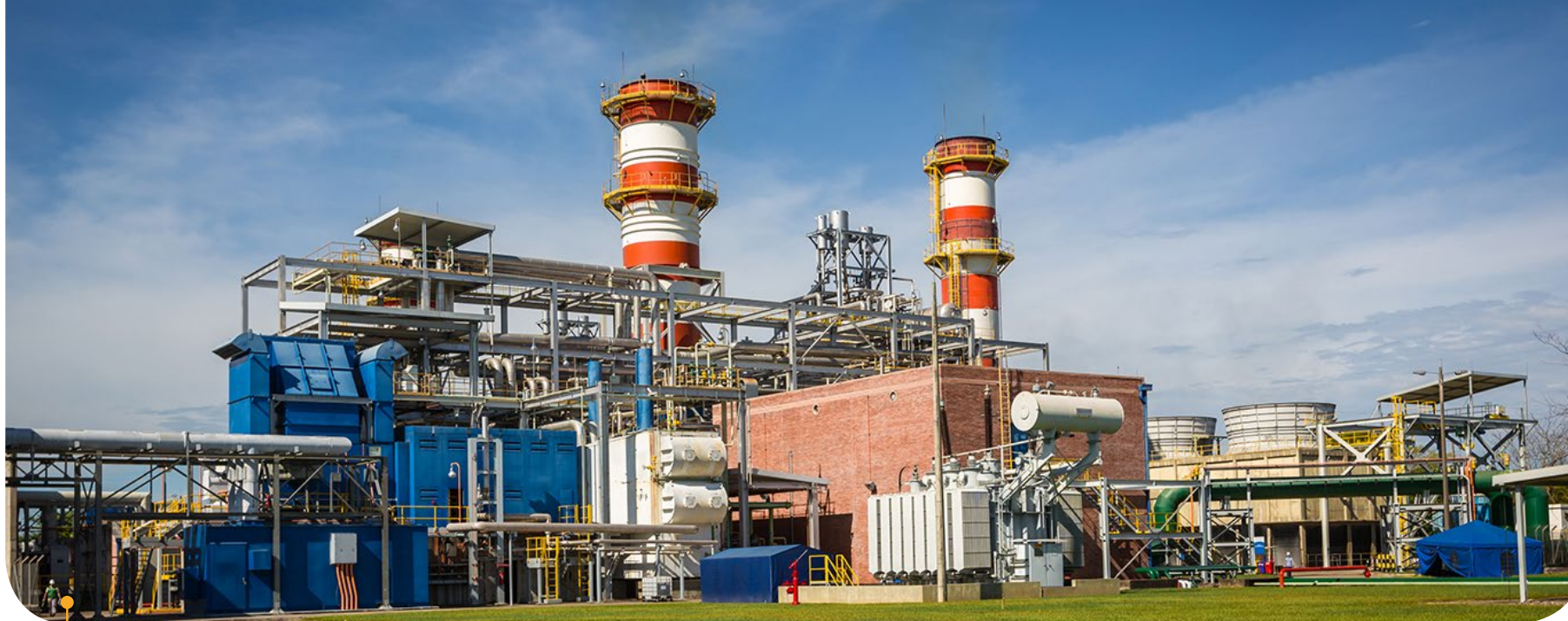
Central Térmica Termocentro (300 MW) en Santander.
