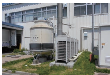
ボイラーからエアコンに切り替え (郡山ヒロセ電機)
