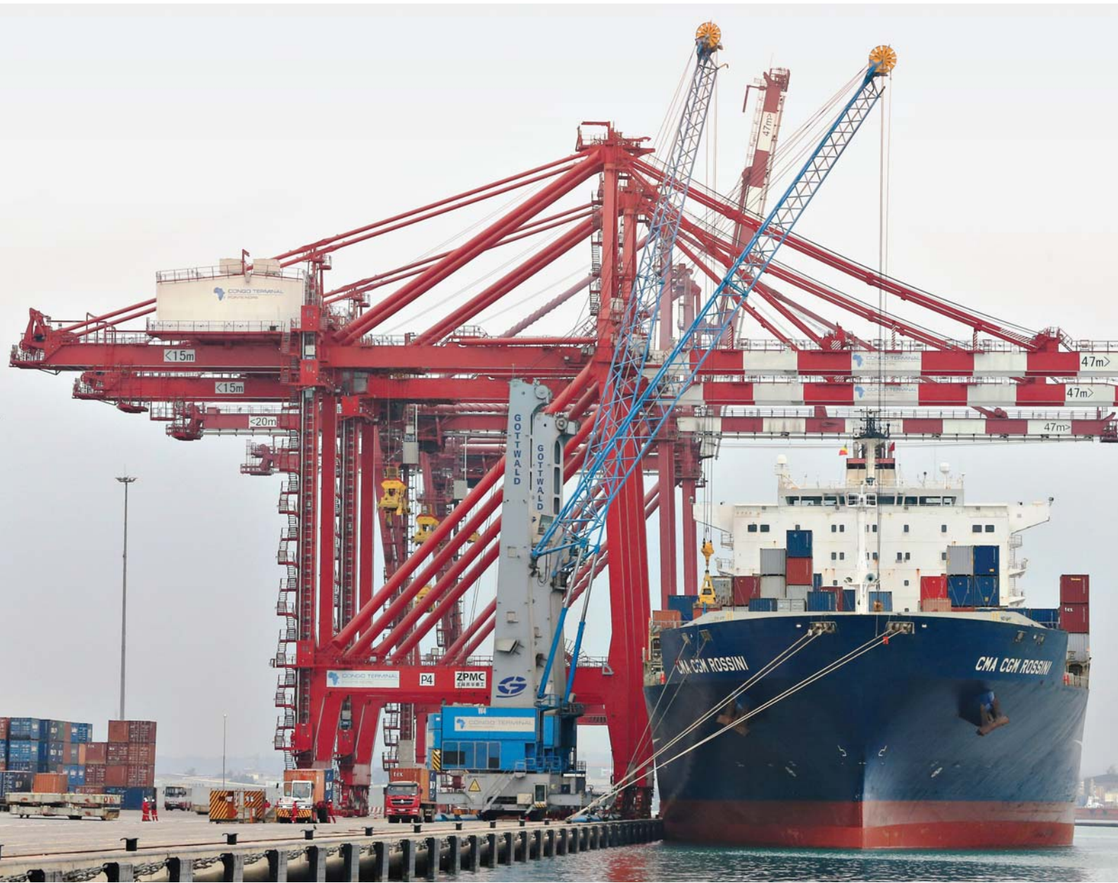
Concession portuaire Congo Terminal à Pointe-Noire, bénéficiant de six portiques capables de manutentionner des navires de 16 000 conteneurs. —
