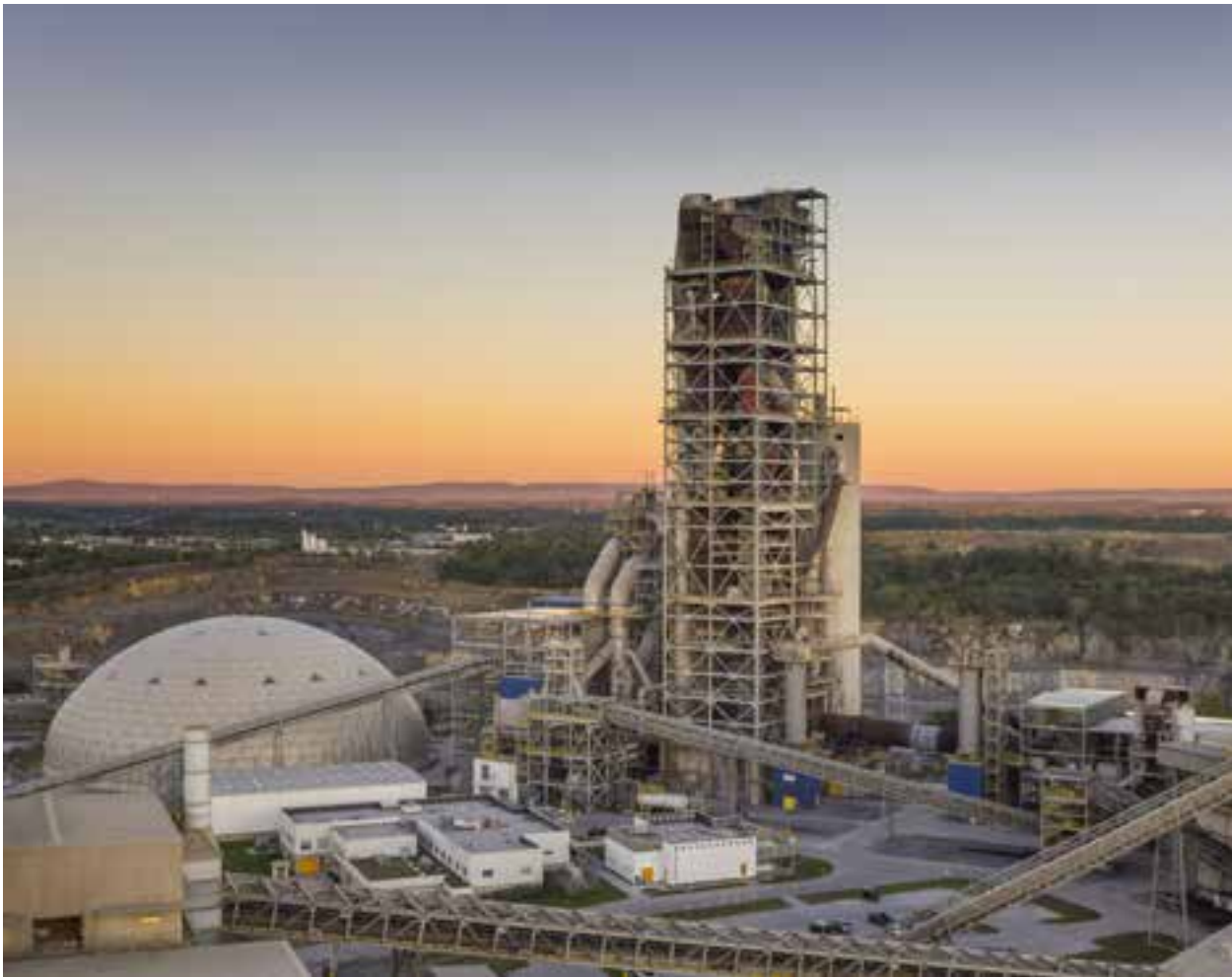
Martinsburg Plant, USA Region
