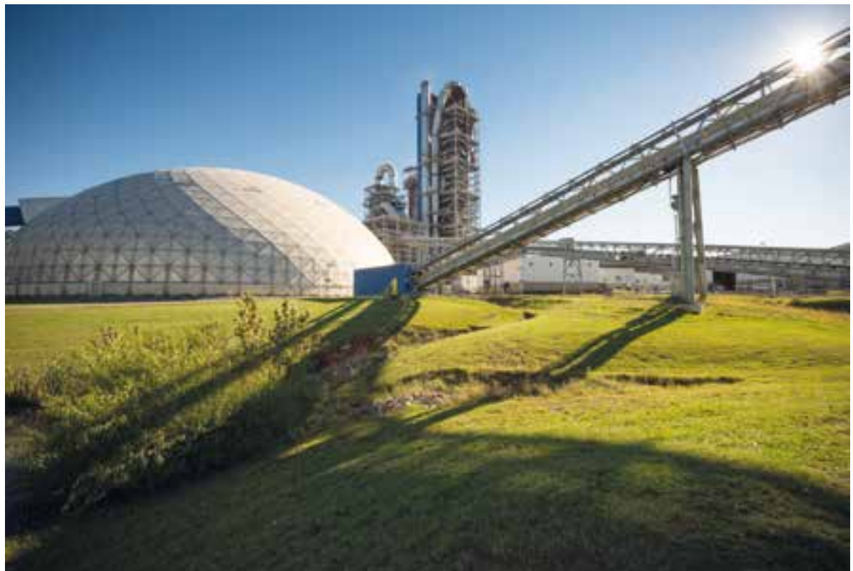
Martinsburg Plant, USA Region
