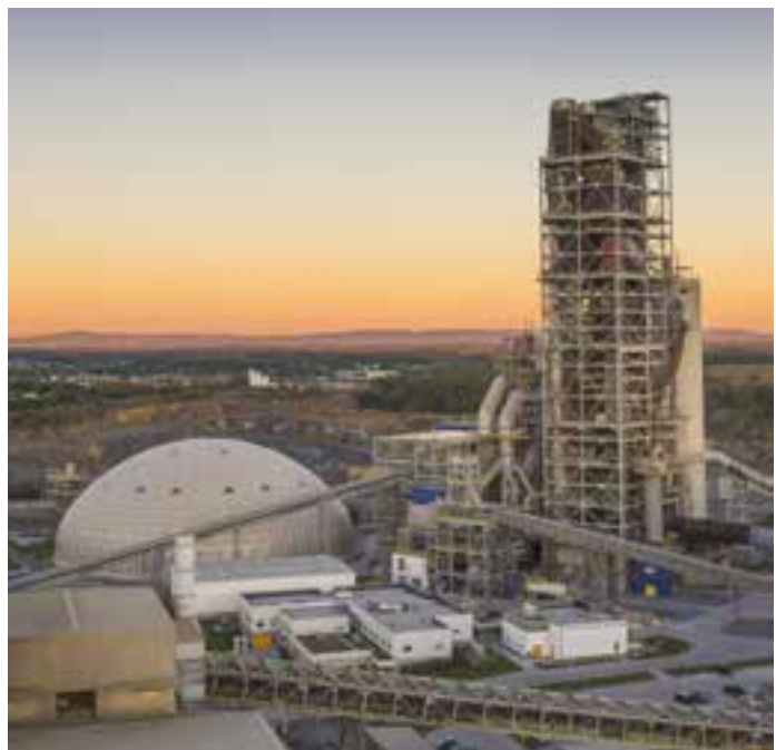
Martinsburg plant, USA Region
