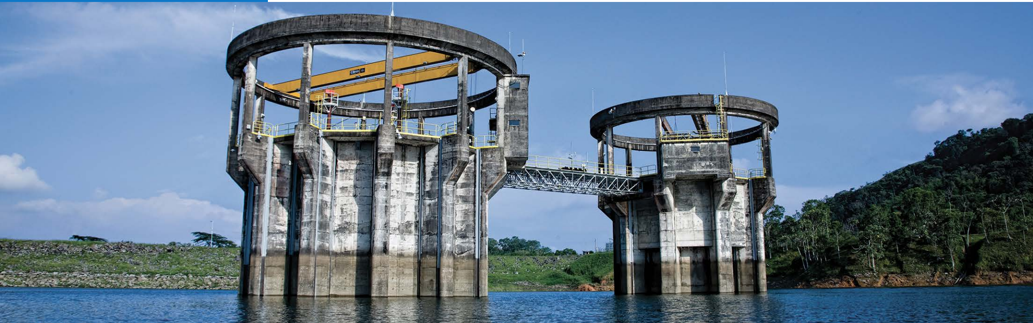
Central Hidroeléctrica San Carlos (1.240 MW).
