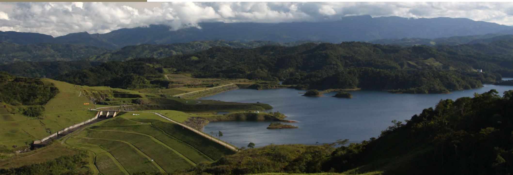
Embalse San Lorenzo, Central Hidroeléctrica Jaguas (170 MW).
