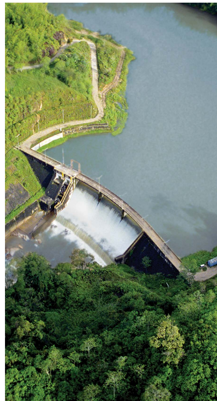
Embalse Central Hidroeléctrica Calderas (26 MW).
