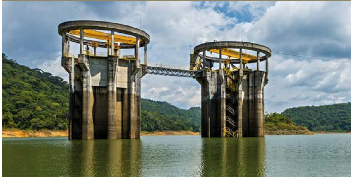
Torres de captación, Central Hidroeléctrica San Carlos (1.240 MW).
