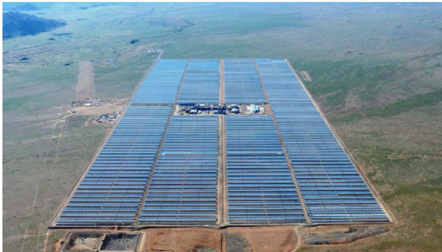
Sudáfrica. Planta termosolar KaXu Solar One
