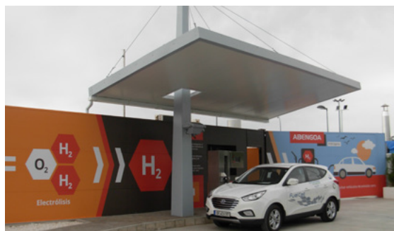
Estación de servicio de hidrógeno
