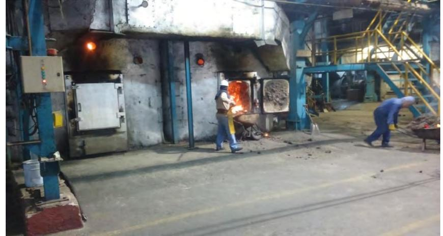
Se implementa la limpieza por turno de las tolvas ceniceras del banco de convección y del pre calentador de aire, esto para evitar que por efectos de la succión del ventilador de tiro inducido se transporte más partículas en los gases.
