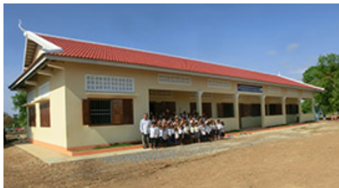
5月に完成した7校目のルン村小学校
