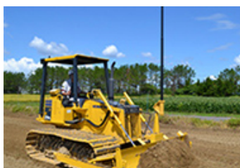
ICTブルドーザーによる整地作業
