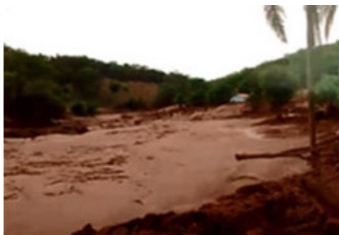
決壊したダムの様子
