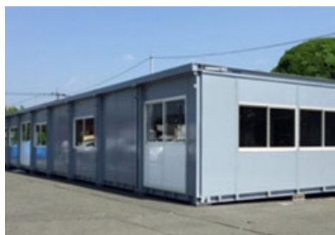
仮庁舎として設置した仮設ハウス
