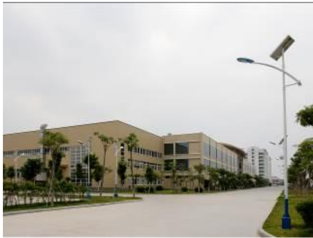
厂内太阳能路灯
