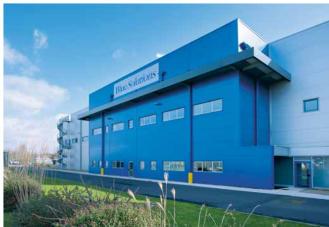
L'usine Blue Solutions en Bretagne.
