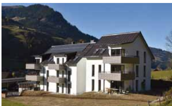
Residential construction project “Feldweg, Kleinarl”, © Salzburg Wohnbau GmbH
