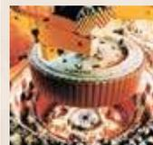
A Siemens instala o primeiro rotor dos 18 geradores de Itaipu, com potência de 823,6 MVA.
