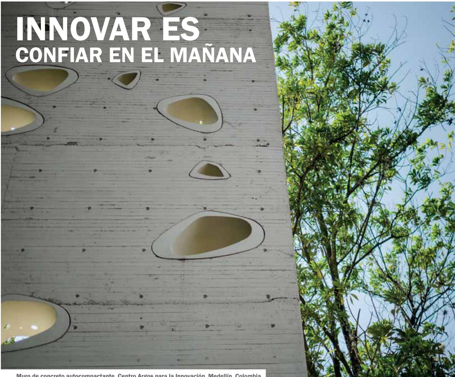
Muro de concreto autocompactante, Centro Argos para la Innovación, Medellín, Colombia
