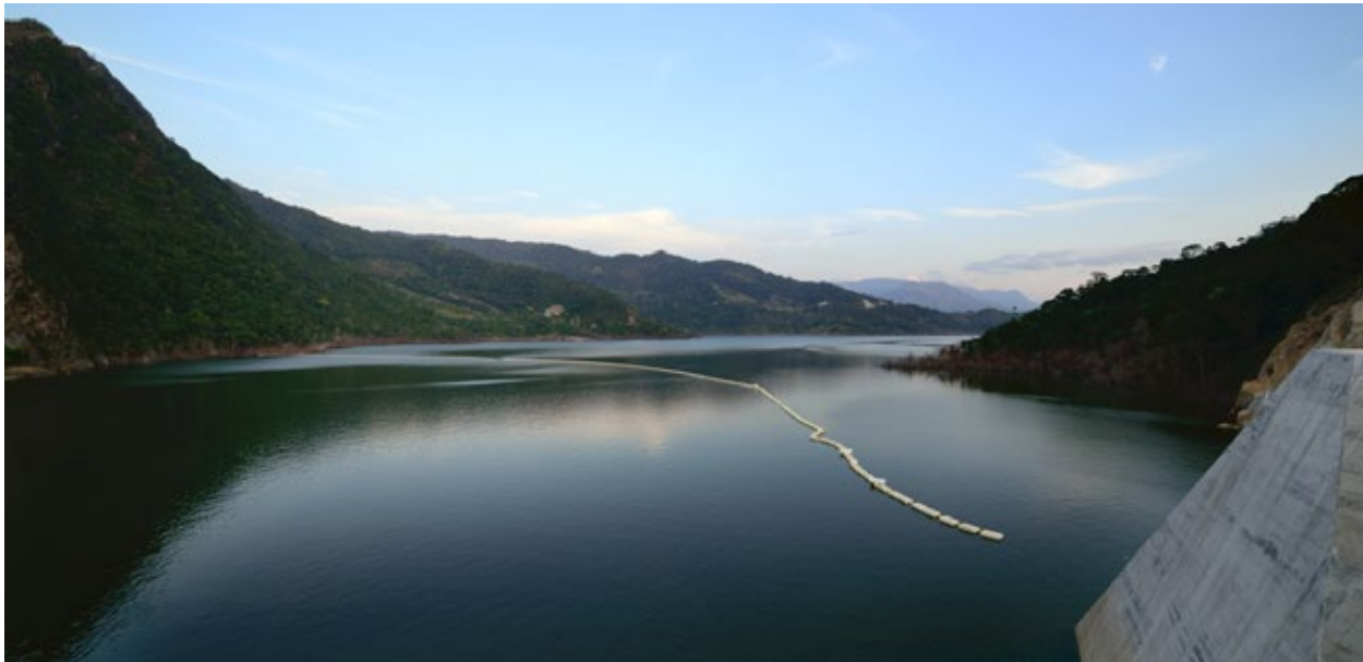
Embalse Topocoro. Central Hidroeléctrica Sogamoso.
