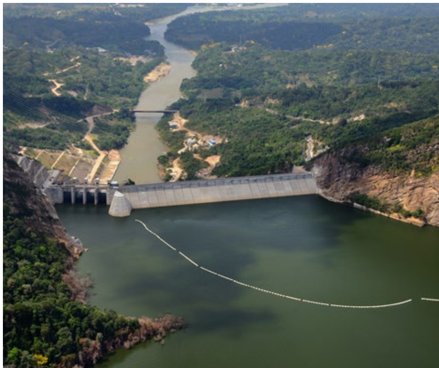
Embalse Topocoro. Central Hidroeléctrica Sogamoso.
