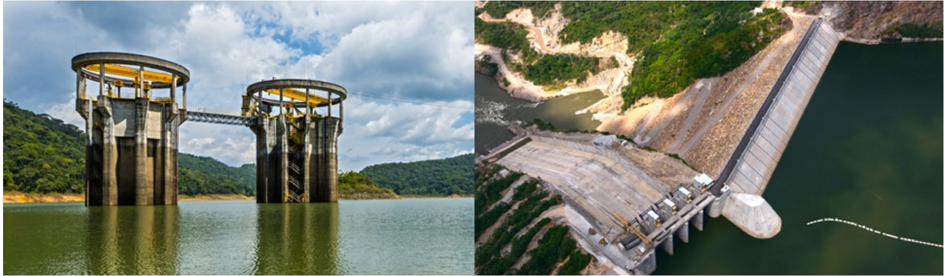
Central Hidroeléctrica San Carlos.
