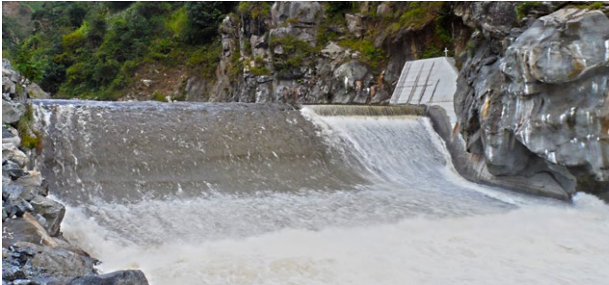
Azud, Central Hidroeléctrica Río Amoyá-La Esperanza.
