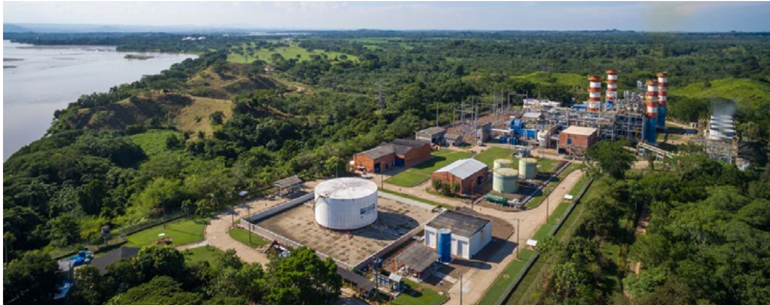
Central Térmica Termocentro.
