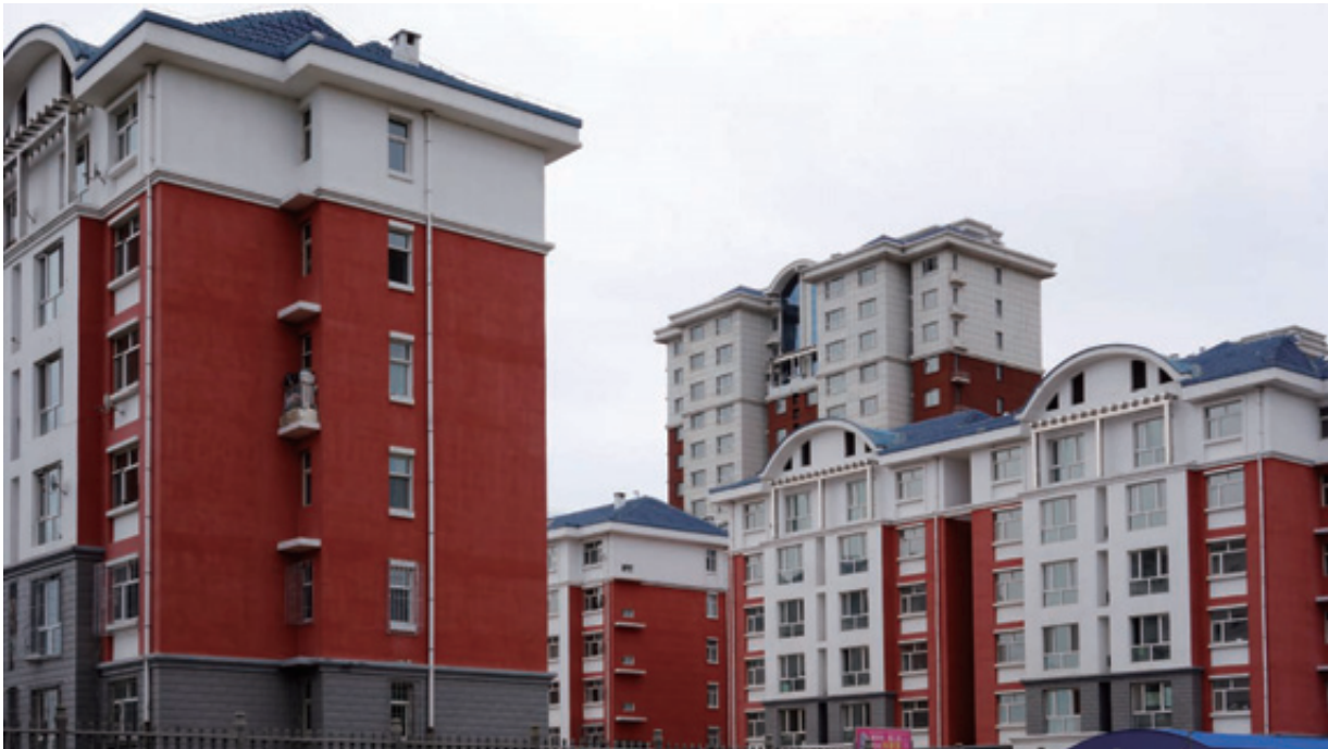
黑龙江分行发行东北地区首支“债贷组合”企业债券，为开发性金融服务东北老工业基地，降低融资成本，加快棚户区建设提供有力支持。图为齐齐哈尔市新建成的新光家园。
