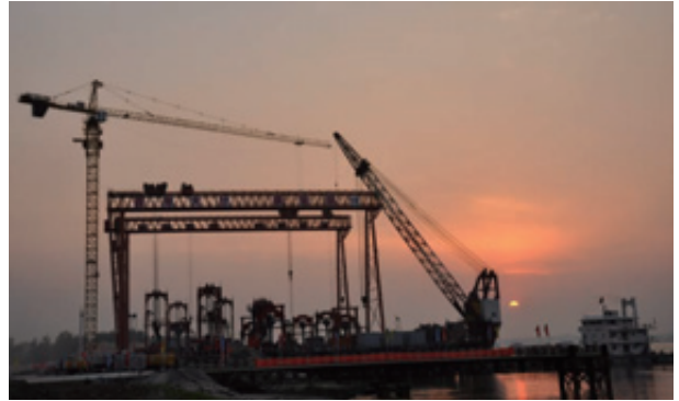
合福铁路安徽段铜陵铁路公路长江大桥
