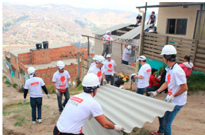
Voluntarios trabajando en equipo en Colombia
