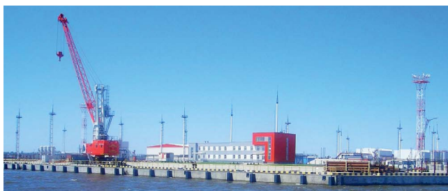
Комплексная транспортно-производственная база по приему отходов производства с МЛСП им. Ю. Корчагина для дальнейшей переработки
