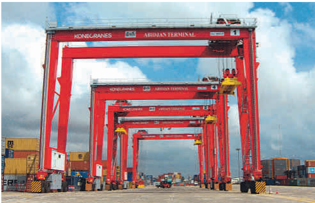
Modern gantry crane, Abidjan Terminal – Republic of Côte d'Ivoire.
