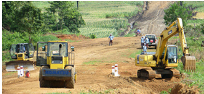
道路建設の様子
