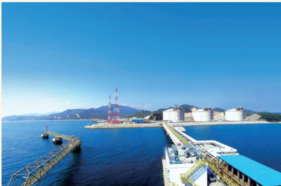
LNG receiving terminal
