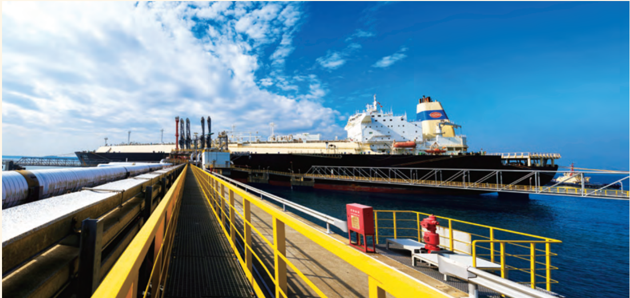
Guangdong Dapeng LNG receiving terminal
