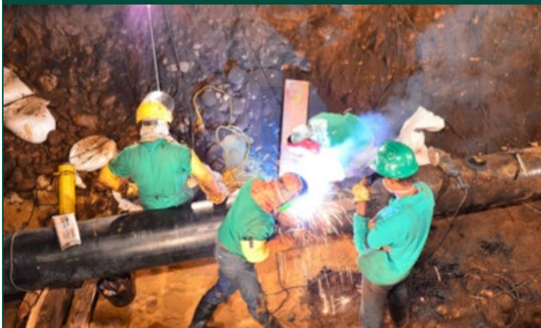
Reparación de oleoductos
