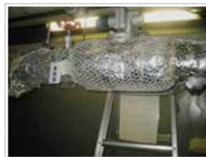
配管への保温材の強化
