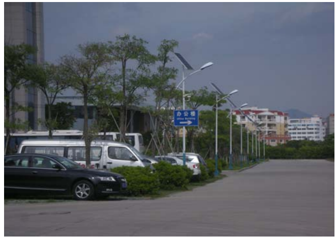
厂内太阳能路灯
