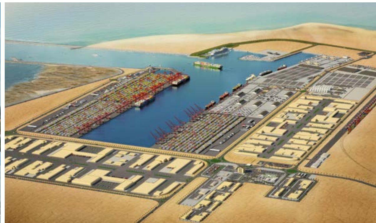
卡塔尔多哈新港建成效果图 The new Doha port in Qatar
