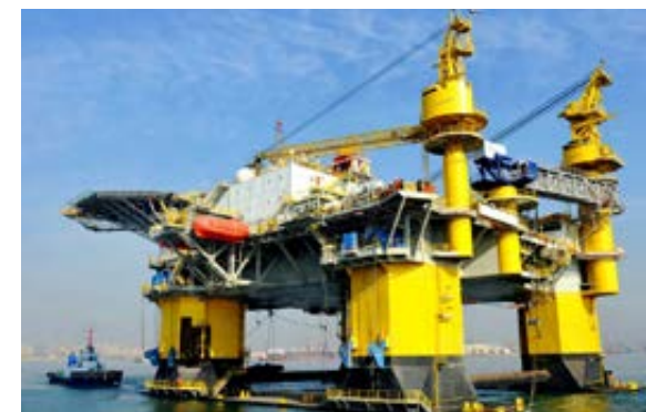
大连船舶建造的新型钻井平台 New Type of Drilling Rig of the Dalian Shipbuilding Industry Co., Ltd.
