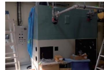
作動中のバイオマスボイラー。間伐材の切削式チップパーも独自開発しました。今後導入予定のバイオマス発電システムでは、発電中の排気熱も漏れなく回収する計画です。
