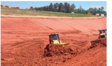
法面（堤防や田んぼなど斜めに固めた土地）の作業も、オペレーターは作業機を動かす必要がなく、車両の位置を動かすことに専念できます。土を抱えすぎることによるスリップを未然に検知し、最適な土量で効率よく施工できるので、オペレーターの負担は最低限で済みます。
