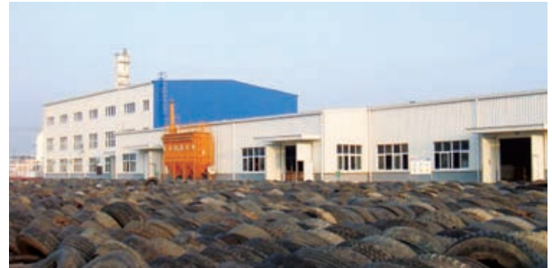
Fujian LNG cold energy low-temperature rubber crushing project
