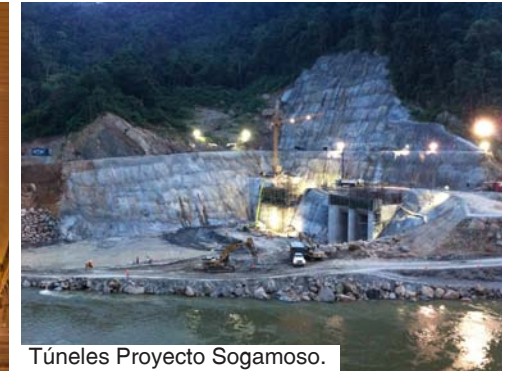
Túneles Proyecto Sogamoso.
