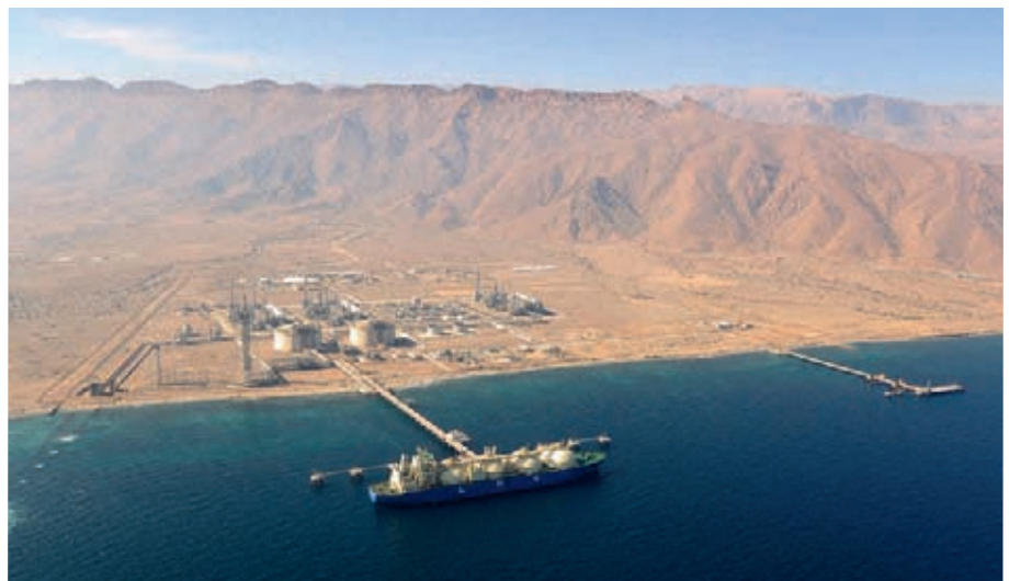
↓ The Oman LNG facility.
