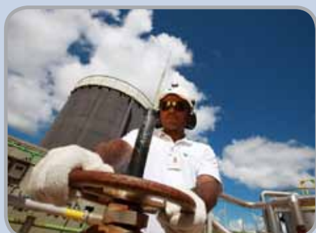
Área das tubulações e tanques – Projeto Carnalita, Vale – Foto de Márcio Dantas
