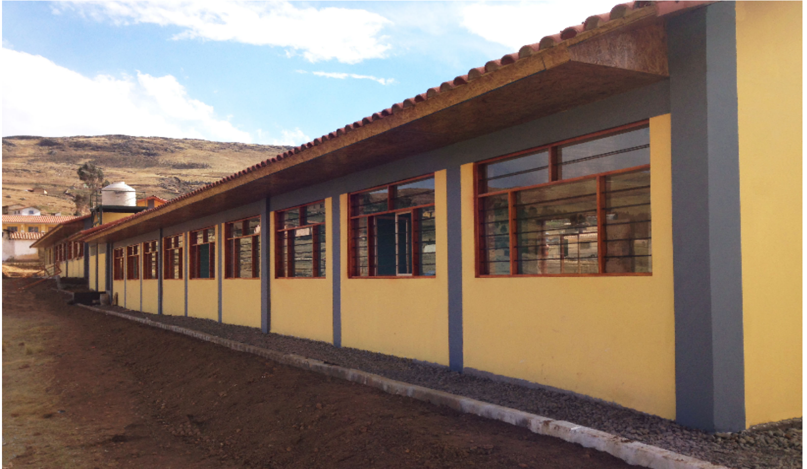
Pabellón de aulas del colegio
