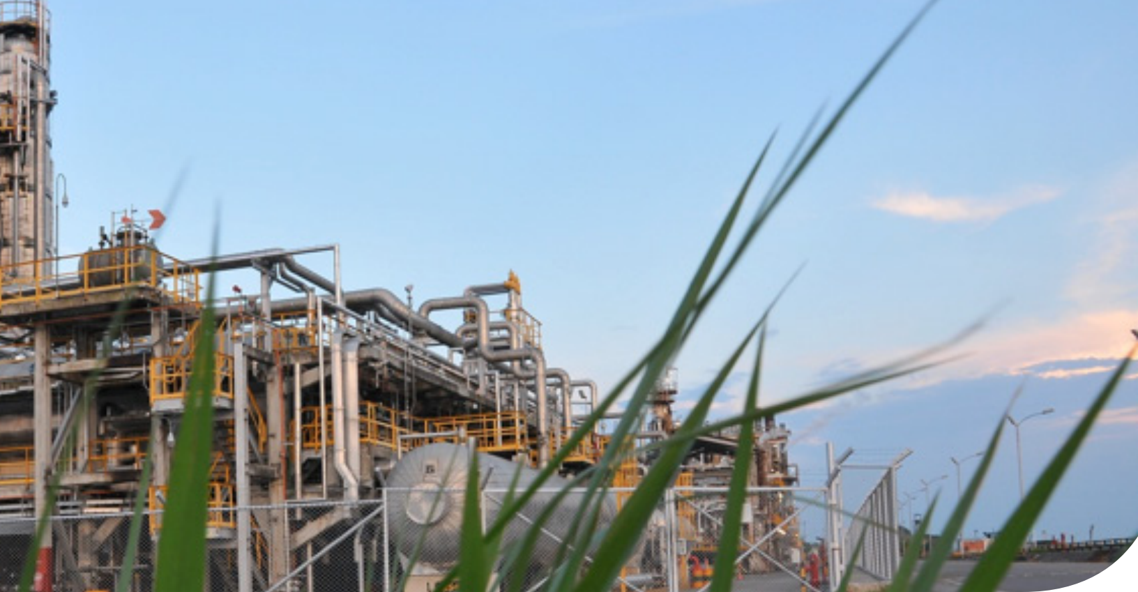
Refinería de Barrancabermeja
