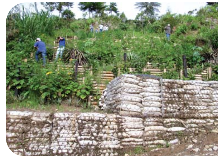
Obras de bioingeniería, vereda Monterredondo, Herveo (Tolima)
