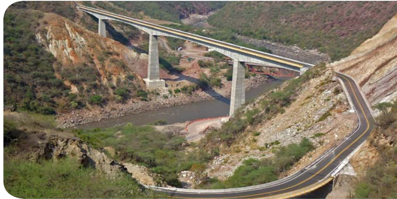
Puente Guillermo Gómez Ortiz
