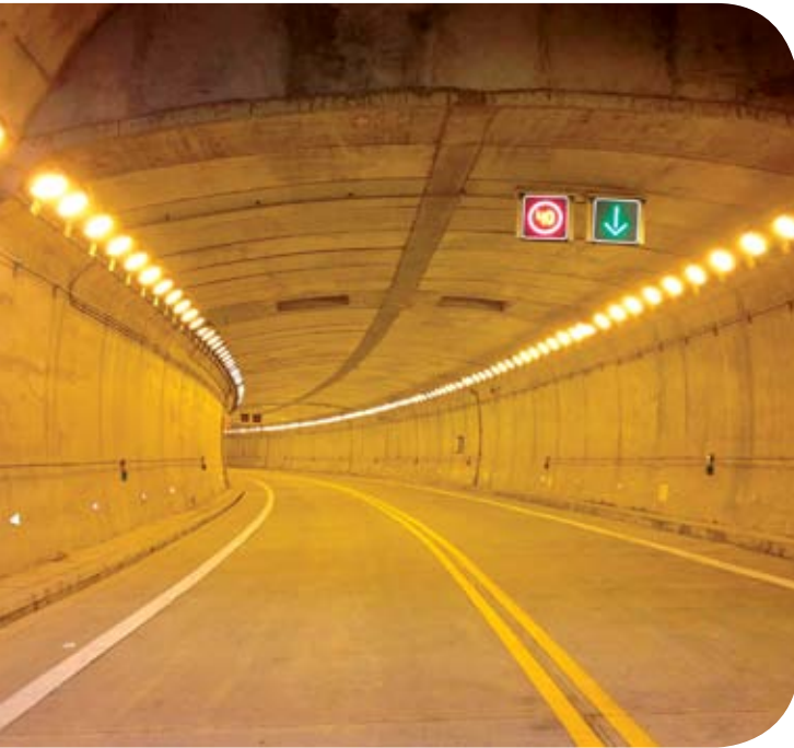
Túnel vial I
