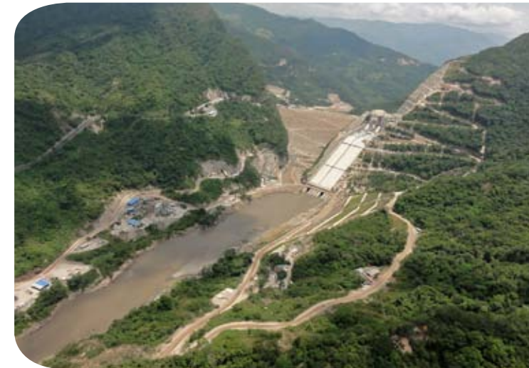
Registramos un 90% de avance en la ejecución del Proyecto Hidroeléctrico Sogamoso.
