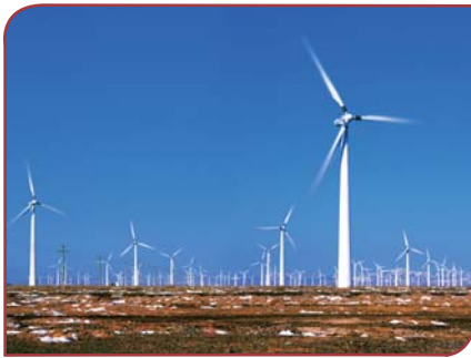
神池风电场 Shenchi Wind Farm
