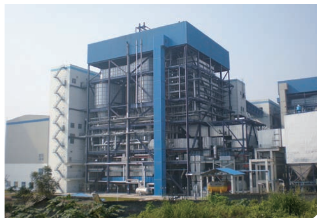
西安热工院研发的世界单机容量最大的循环流化床锅炉
