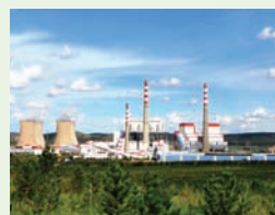
第一个大型煤电一体化项目
