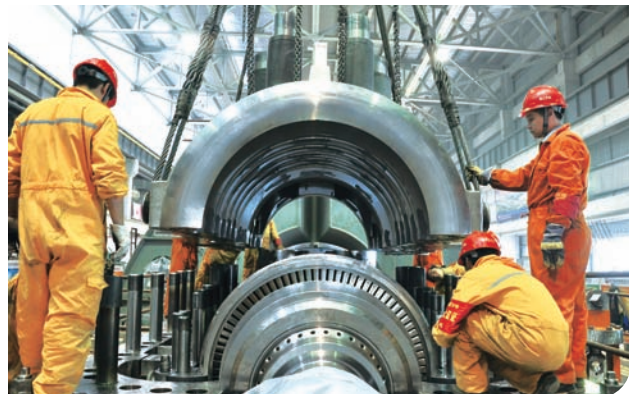
设备安装调试
