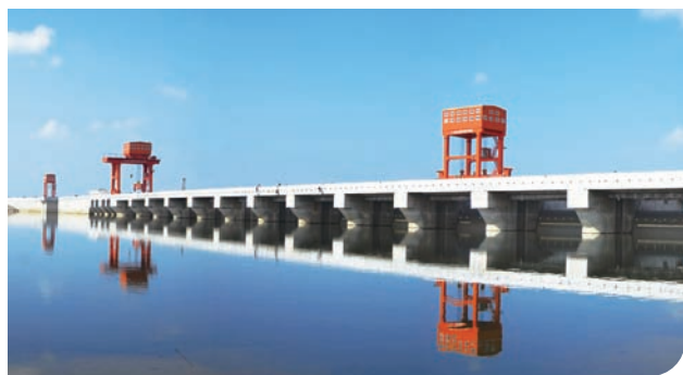
华能戈枕水电站
