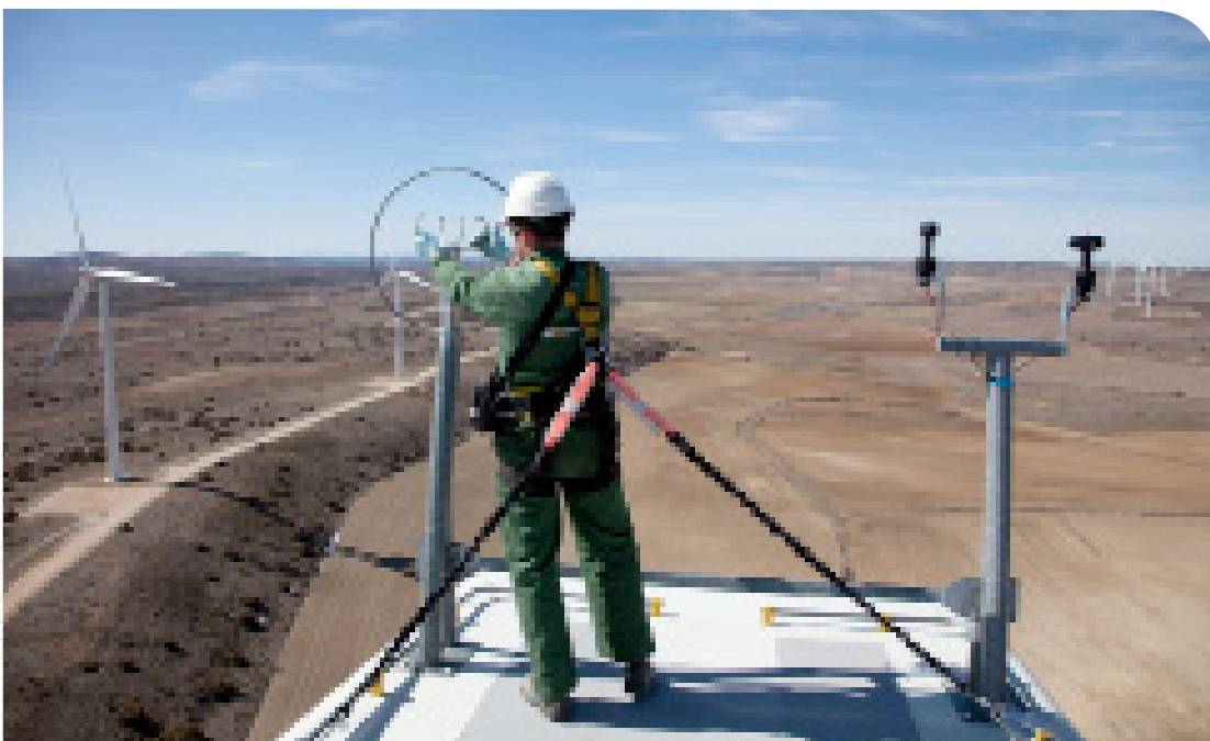
Trabajos en el parque eólico de Maranchón (Murcia, España).
