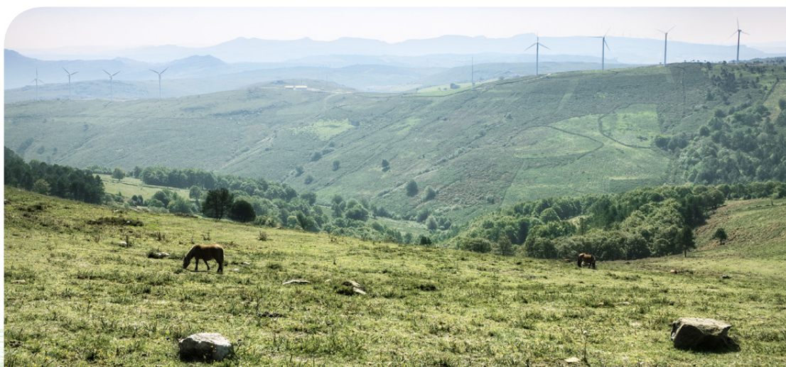
Parque eólico de Valdeporres (España).
