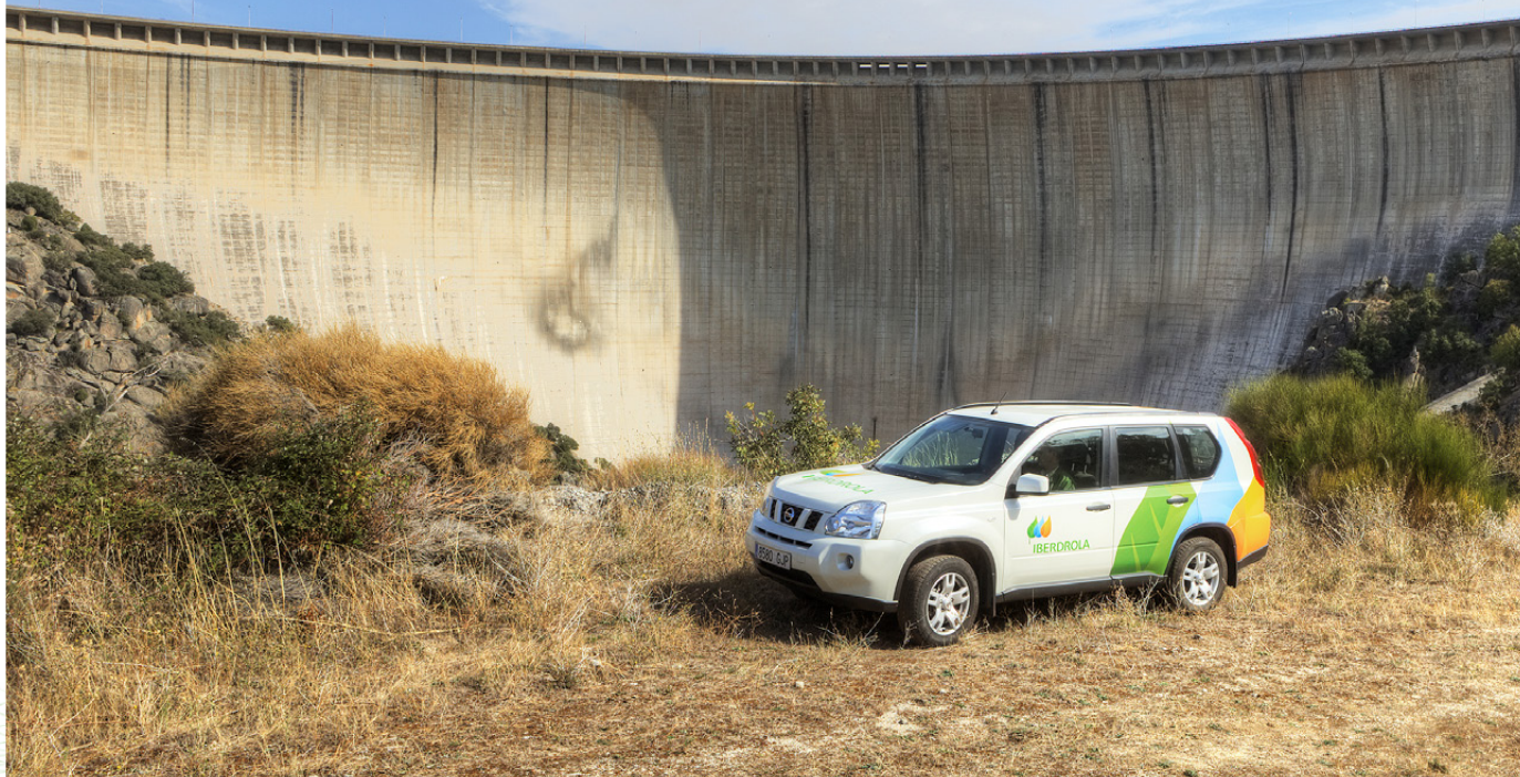
Presa de la central hidroeléctrica de La Almendra (Salamanca, España).
