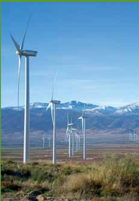
Wind energy complex at El Marquesado (Granada).
