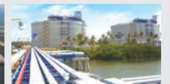
Manzanillo, Mexico LNG Terminal Project
