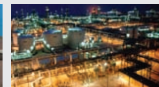
Ras Laffan, Qatar LNG Project
