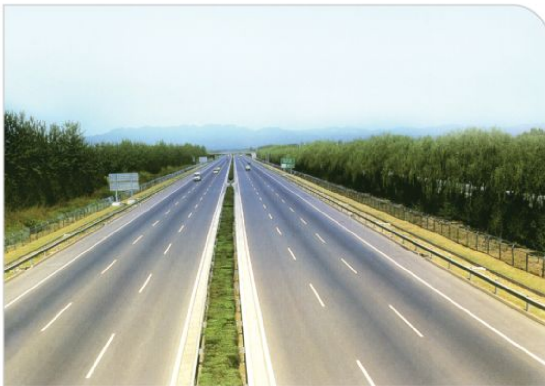
P1 北京八达岭高速公路 Beijing Badaling Expressway
