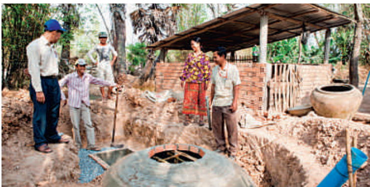
Installation d'une unité de biogaz (crédit EcoAct - SNV).
