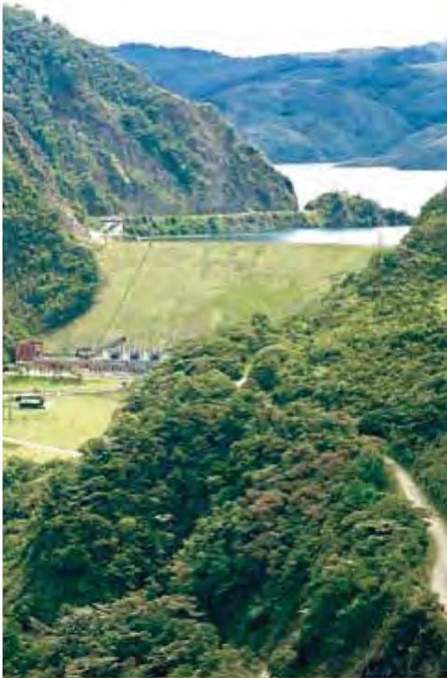
Central hidroeléctrica Calima, Valle del Cauca.
